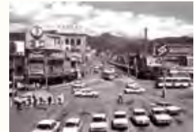
松本駅前広場と駅前通り (昭和46年)
